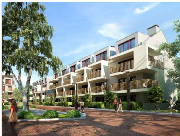
• Malinowe Moderna I, Cracow
